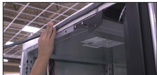
Fig. 49 Apply foam tape (Medium Temp)
