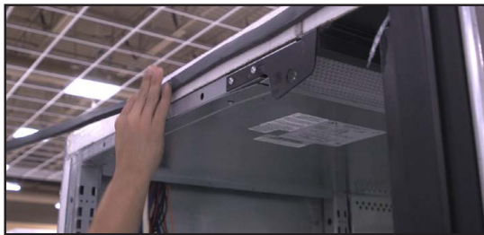
Fig. 40 Apply foam tape (Medium Temp)
