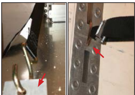
Fig. 2 Unhook strap from wall
