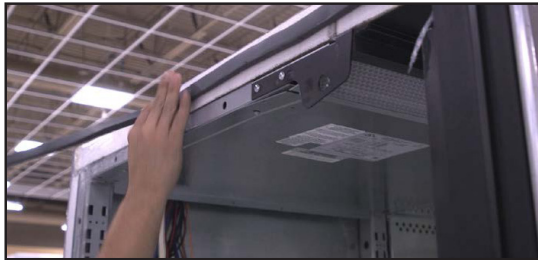
Fig. 40 Apply foam tape (Medium Temp)
