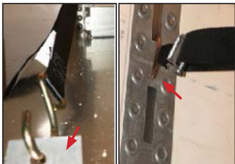
Fig. 2 Unhook strap from wall
